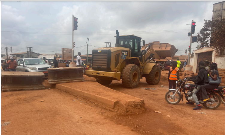
Route en chantier barrée au carrefour Obili.
