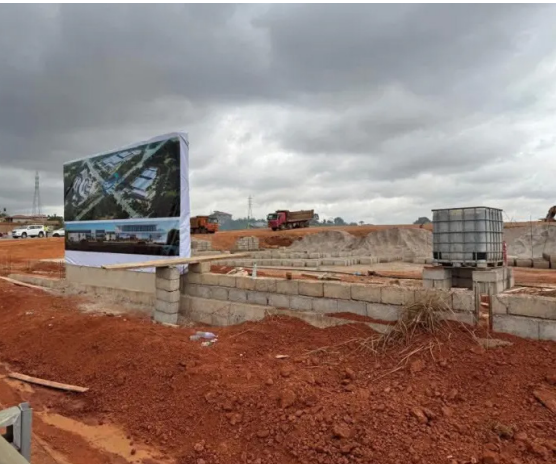
Le site du futur complexe hospitalier Yichen pharmaceutical en construction.
