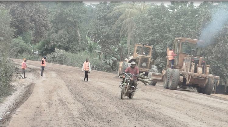
L’entreprise Arab Contractors en plein travaux de réhabilitation sur l’axe Yaoundé-Evodoula. Le 18 août 2025 à Okola.
